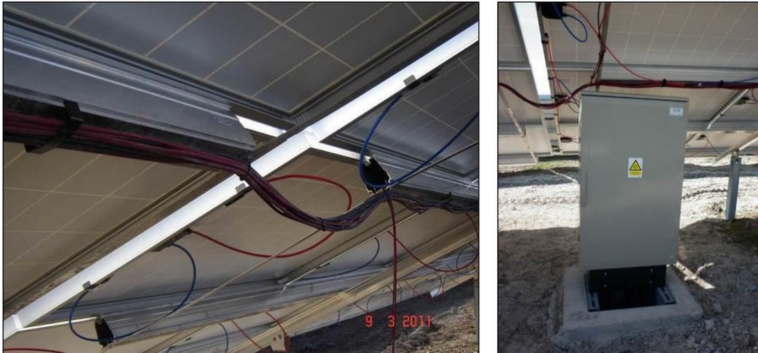
*Illustration de boîtes de jonction et de raccordement*
